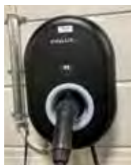
Tilvalg veggmontert ladestasjon (Wallbox) med Type 2 ladekabel, A464548
