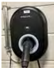
Opcjonalna stacja ładowująca naścienna (Wallbox) z kablem ładowującym typu 2, A464548
