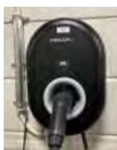
Estación de carga montada en la pared ("Wallbox") opcional con cable de carga Tipo 2, A464548
